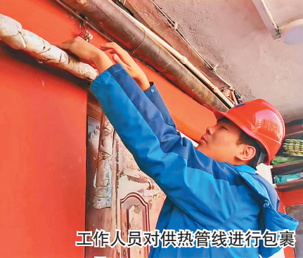
工作人员对供热管线进行包裹
