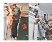
维修人员立即关闭了该单元的 供热阀门,准备更换新的弯头,由于 弯头位于立厅上方,维修人员只能双 脚踩在梯子上,尽量保持身体平衡, 才能空出双手进行维修。经过3个 多小时的艰难维修,终于成功更换了 弯头,消除了堵塞,此时维修师傅身 上的衣服已经被汗水湿透。经循环 后测量,该单元的供热温度显著提 4组暖气、12米供热管线堵塞
