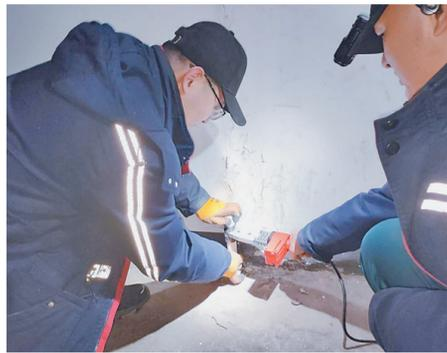
最近,巩大娘打电话给哈投股份供热公司报修,称自己家的暖气冰凉。检修组长李洸琦和检修工马凯立刻带上工具,到巩大娘家查看情况。二人检查发现存在夹气现象,立刻进行了串水排气处理。李洸琦在服务过程中询问巩大娘家的供热情况,巩大娘表示家中温度常常不理想,暖气有温度,但不太热。李洸琦判断,巩大娘家的管线可能因老化导致局部堵塞,影响了流速与散热。李洸琦告诉巩大娘,这次排气串水后先观察观察,若是没有转变,将为其进行管道改造。
