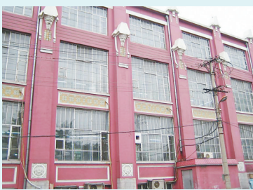
砖混结构,为装饰艺术运动建筑风格。走进这处建筑,目之所及,皆是“文物”,堪称走进了一处印刷博物馆。
