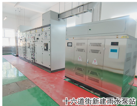
十六道街新建雨水泵站
