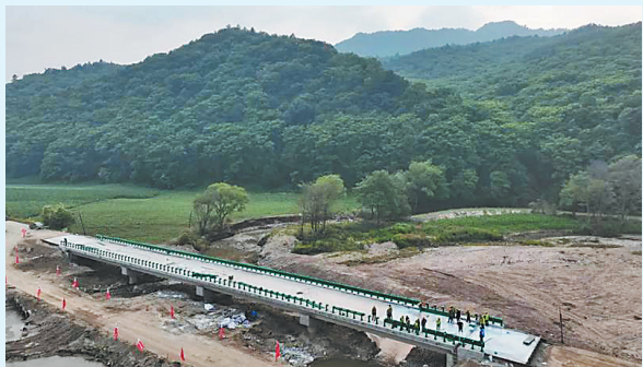
曙光1号桥桥梁附属波形护栏安装 省交通部门提供
