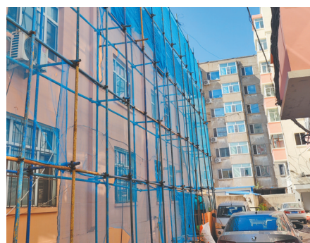
芦家街29号院废弃锅炉房成公司办公楼
