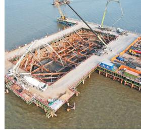
生活报讯(陈晓光 记者栾德谦)经过一周不间断地施工作业,9月29日,哈尔滨都市圈环线北环松花江特大桥主航道桥主墩大体量承台混凝土浇筑施工顺利完成。至此,北环松花江特大桥拱桥、斜拉桥、连续钢构桥基础工程全部完成。主航道桥承台“破水而出”,标志着主航道桥即将进入塔座和塔身施工新阶段。图片由省交通部门提供
