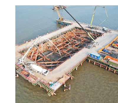
生活报讯(陈晓光 记者栾德谦)经过一周不间断地施工,9月29日,哈尔滨都市圈环线北环松花江特大桥主航道桥主墩大体积承台混凝土浇筑施工顺利完成。至此,北环松花江特大桥主航道桥承台“破壳而出”,标志着主航道桥即将进入塔座和塔身施工新阶段。图片由省交通部门提供
