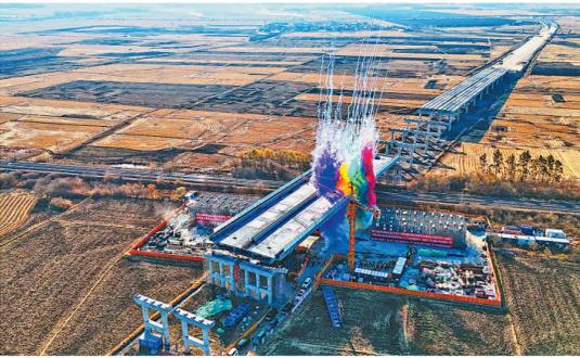
生活报讯(记者李静 实习记者栾德谦)18日,铁科高速公路铁风段约13000吨的混凝土连续梁完成逆时针转体74°14'40",与引桥精准对接...
