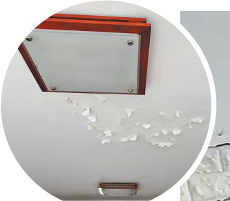
王女士家中,再次查看情况,现场协调解决方案。相关负责人表示,将找专业的施工单位对该户南北阳台、檐沟接缝等关键部位进行全面排查,查清漏水原因和具体点位后进行彻底维修。
