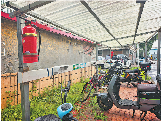
整改后，电动车充电站配备了灭火器。拍摄于7月3日
