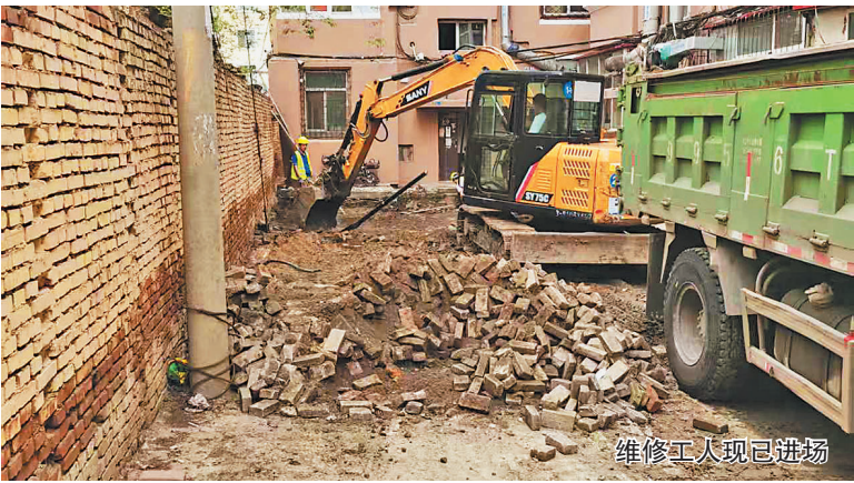
维修工人现已进场
