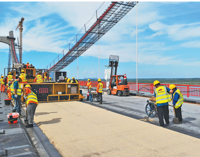
生活报讯(记者栾德谦)近日,哈尔滨都市圈环线西南环段项目工程
