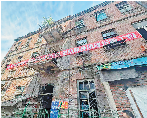
现场老住户见证拆除
