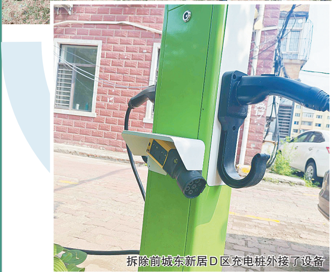
拆除前城东新居D区充电桩外接了设备
