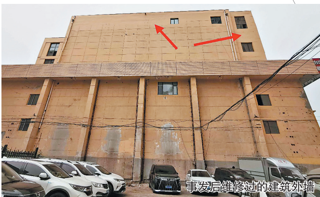
事发后维修过的建筑外墙
