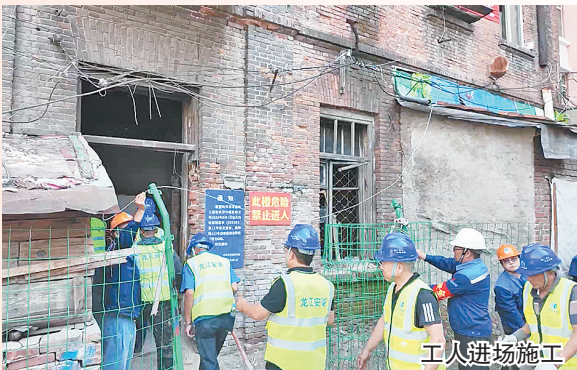
工人进场施工
